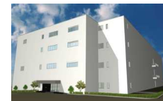
NEC Kanagawa data center
